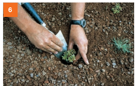
6 De plantstekjes planten en licht aandrukken. Belangrijk is dat de plantenstekjes licht met substraat bedekt zijn. Aansluitend met water aangieten en bemesten.
