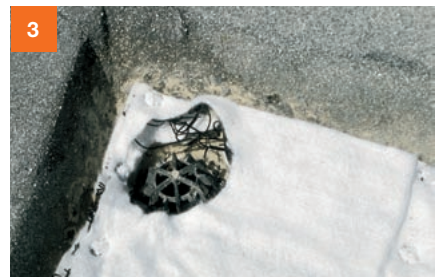
3 Ter plaatse van hemelwaterafvoeren een sparing in de Bauder SDF mat maken. Als er geen mogelijkheid is een controleschacht aan te brengen moet rondom de hemelwaterafvoer grind aangebracht te worden.
