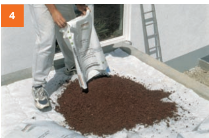
4 Rechtstreeks op Bauder SDF mat twee zakken plantaarde per m 2 aanbrengen. Bauder SDF mat altijd direct ballasten.
