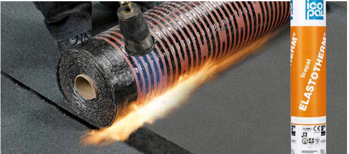
Toepassing van Elastotherm dat aan de onderzijde is voorzien van Power-Thermstrepen.
